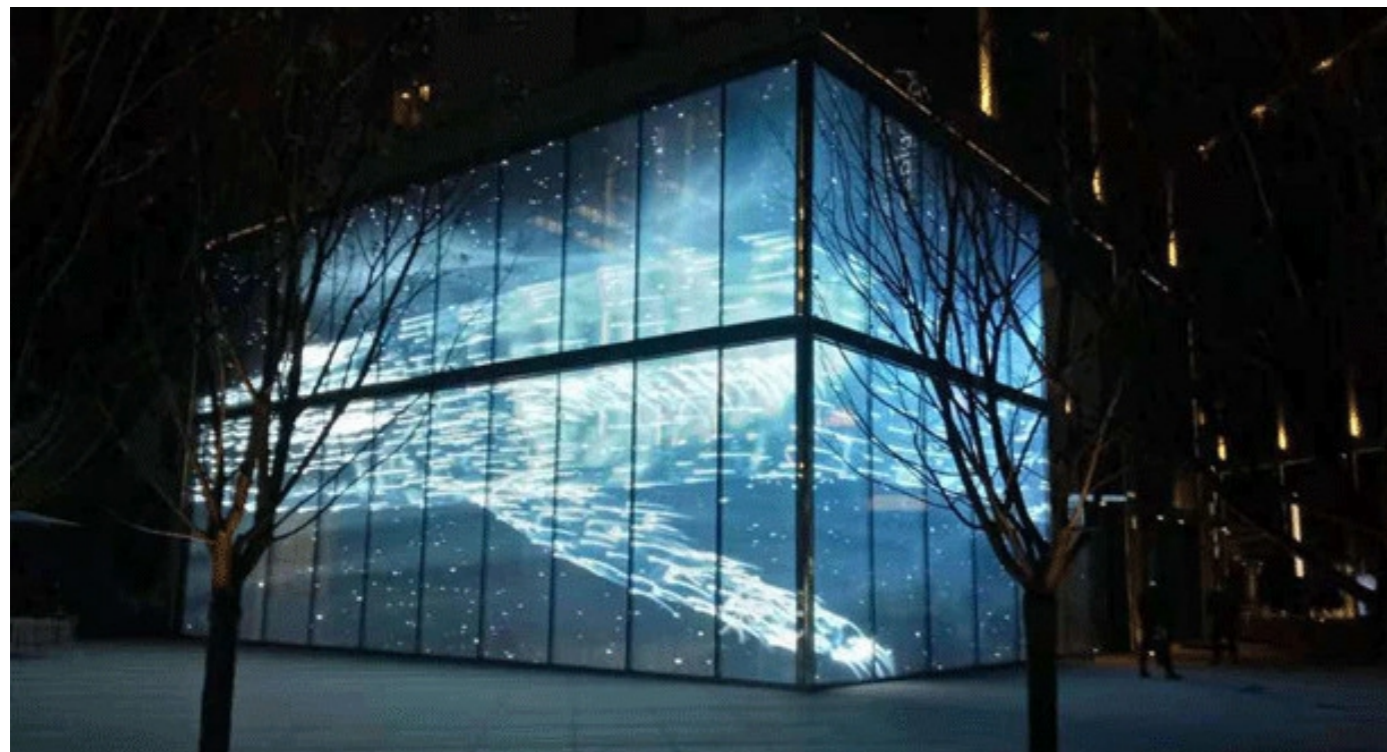
杭州良渚未来之光项目
